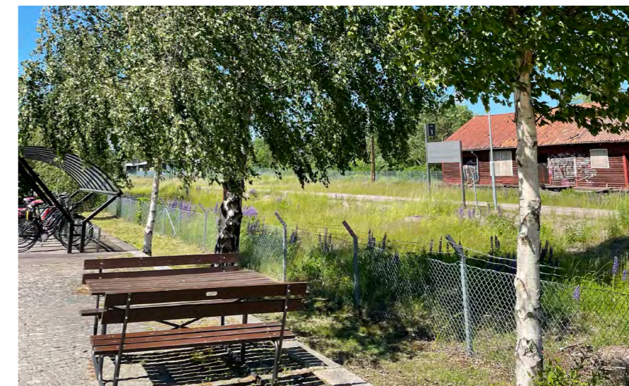
Figur 3.3 Stationen är idag utrustad med parkbänkar och cykelparkering. Planterad björkallé markerar en av de gamla stensatta perronger som ingår i det av kommunen utpekade kulturmiljövärdet.
