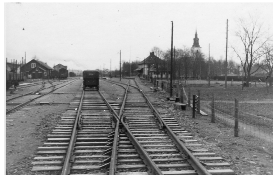
Figur 2.11 Fotografi av Heby station från omkring 1931. I bakgrunden syns de båda magasinbyggnaderna, Heby stationshus och Våsterlövsta kyrka. Alla fyra byggnader ingår i det kommunalt utpekade kulturvårdsområdet kring stationsmiljön.
