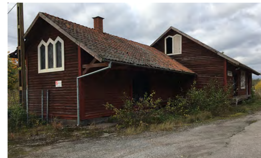
Figur 3.11 Övergiven magasinsbyggnad norrväst om stationen.
