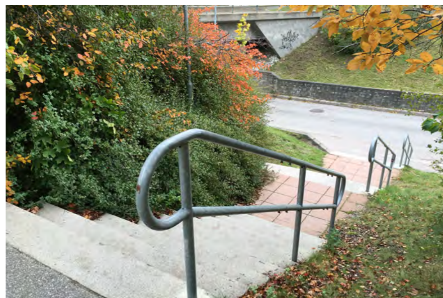
Figur 3.31 Trappa som leder till befintlig passage under spåret.
