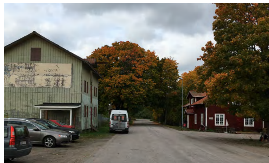
Figur 3.10 Övergiven magasinsbyggnad norr om spåret.
