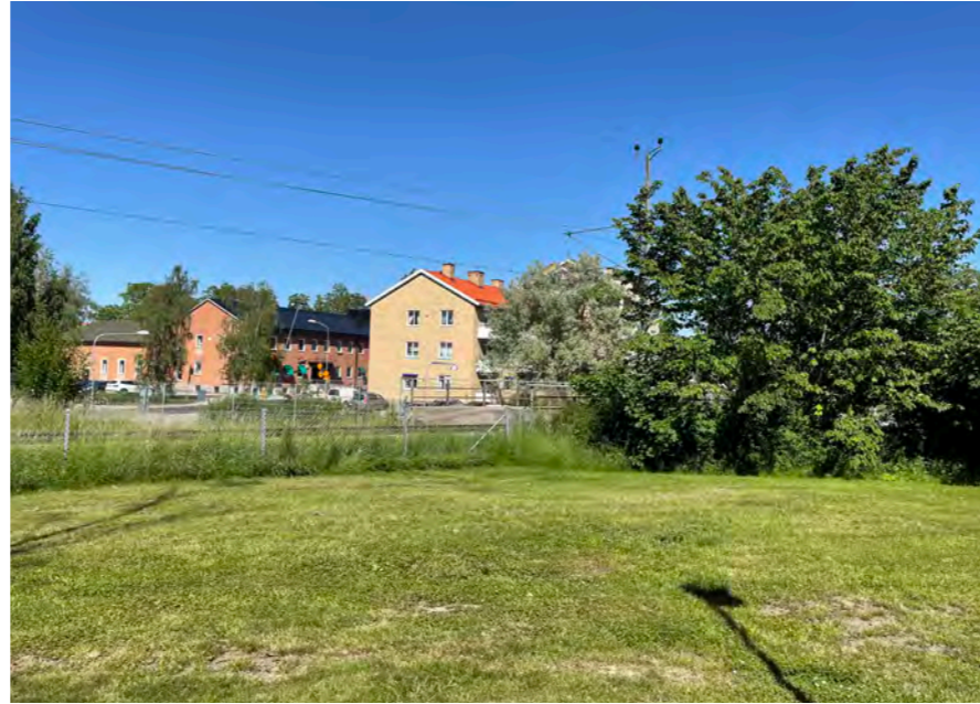
Figur 2.1 Bebyggelse i anslutning till spåren.
