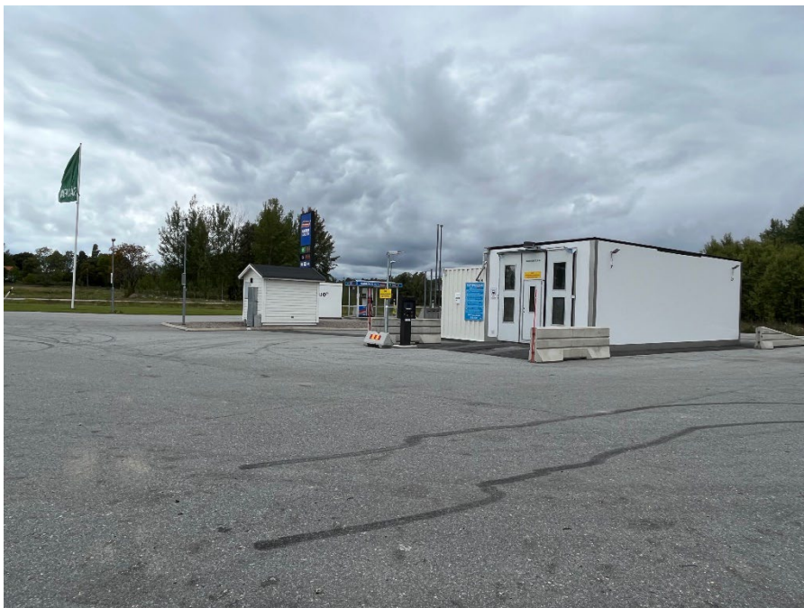
Bild tagen över tvätthall och drivmedelsstation på fastigheten Forsbro 1:119.
