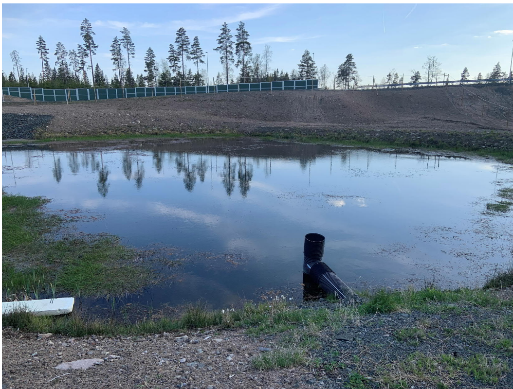
Foto 17. Exempel på en relativt nyanlagd våt damm. Utsläppsanordningen syns i förgrunden.
