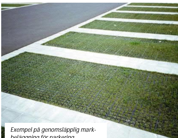
Figur 19 och 20. Bilder som visar utformning av lokal markinfiltration respektive plantering för dagvattenrening
